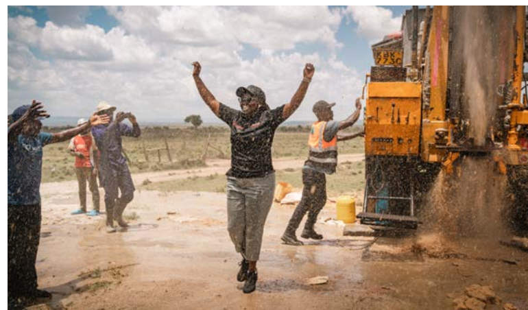
„Flushing“ in Gemeinde, bei dem ein neu gebohrtes Brunnenloch erstmals testweise durchgespült wird und das saubere Wasser als erste sprudelnde Fontäne an die Oberfläche bricht
